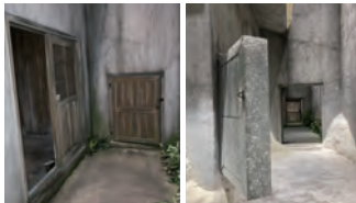
通路と医務室
