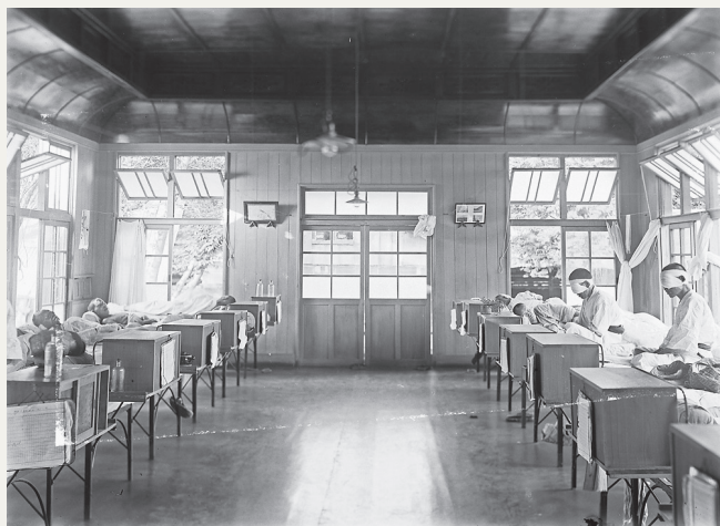
重病室(6病室) 昭和17年
