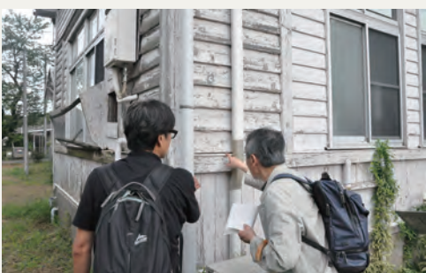
全生園旧図書館外壁の状態を確認する 藤岡委員（右）
