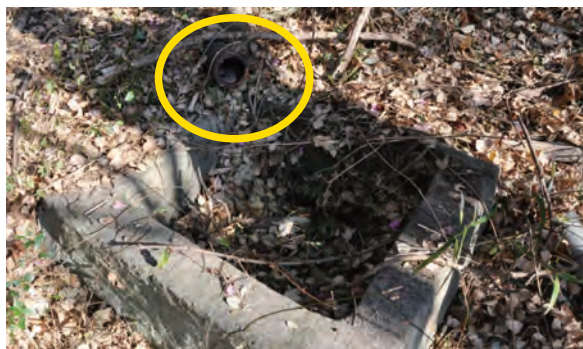
51 コンクリート製の水溜め。送水管が地面から顔を出している(丸囲み部分)。上には別の段々畑があるので、山から出る余り水をもらった貯水槽か。
