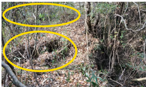
[91] 左上に僅かに「光愛道路」のガードレールが見える。道路のすぐそばに「九反田」の溜池施設がある。崩れて穴が空いている部分が水門で、ここを通して溜池から堤へ水が注がれる。
