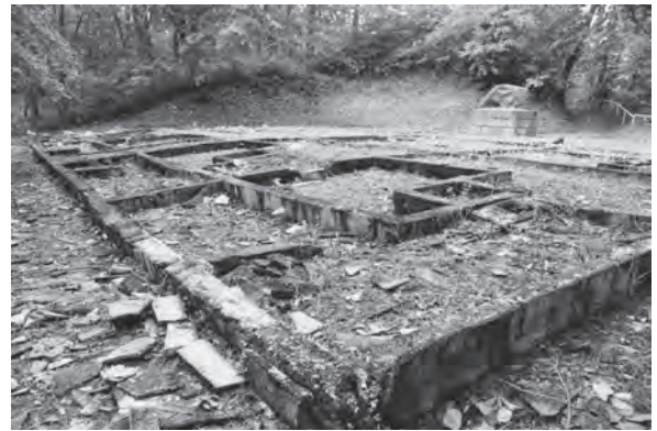
重監房跡。基礎上面には鉄骨は全くない。 （2012年6月撮影）
